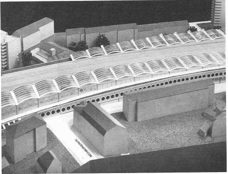
Modellansicht von Westen. Der Autobahn vorgelagert ist die Überdeckung der Auffahrtrampe sichtbar
