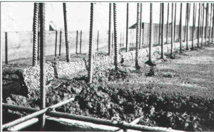
Erstellen einer Anschluss-Dichtung "BFL-MASTIX" Typ 20/70 R4.
