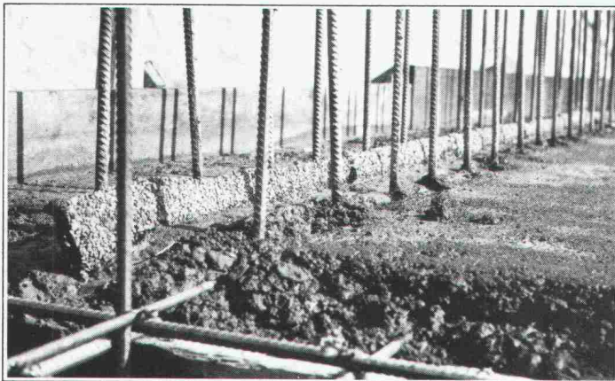
Erstellen einer Anschluss-Dichtung "BFL-MASTIX" Typ 20/70 R4.
