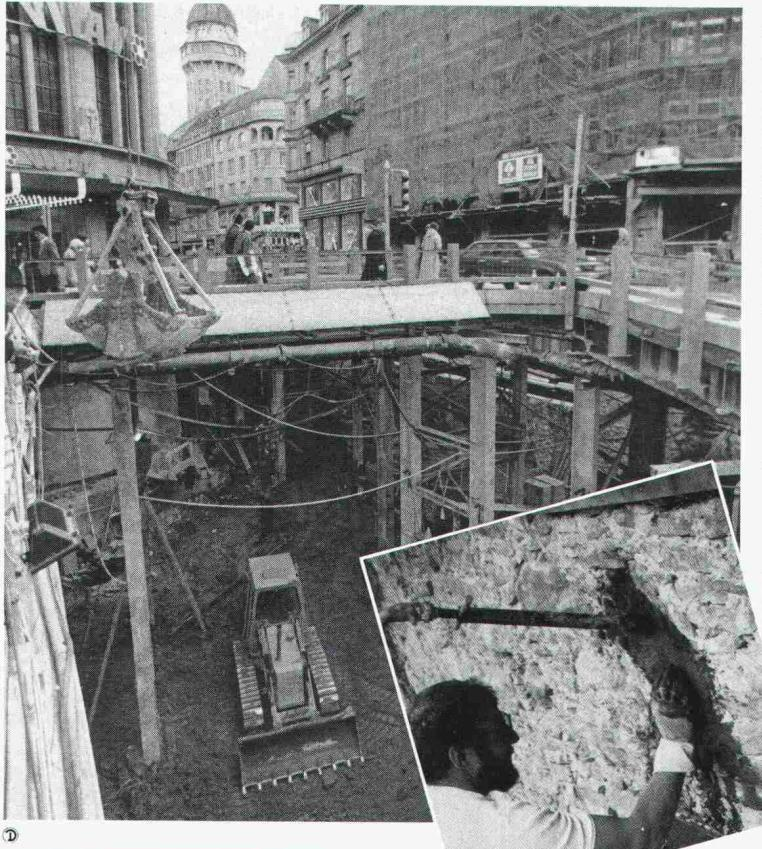
Auch zur Erhaltung wertvoller historischer Bauwerke werden die modernen Mittel und Methoden der Renesco mit grosstem Erfolg eingesetzt. Risse und lockeres Mauerwerk lassen sich mit bewährten Injektionstechniken dauerhaft verkleben und verfestigen. Die Stabilität des Bauwerkes wird wiederhergestellt. Dürfen wir Sie informieren und beraten?
