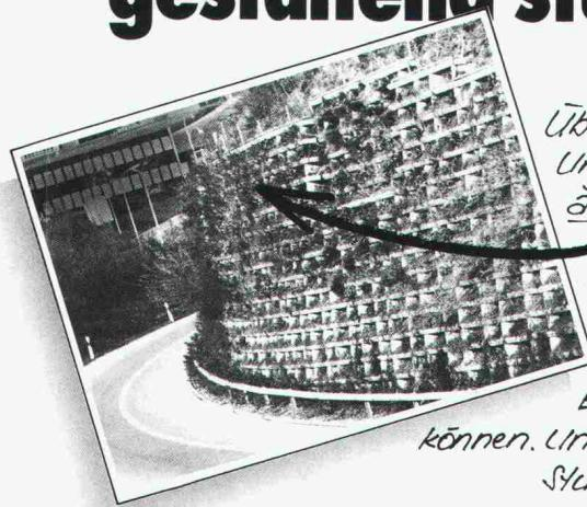
Überall, wo ein steiler Abhang Unterstützung braucht und erst noch ästhetisch aussehen soll, ist Murflex® mehr als am Platz. Die optimal begrünbare Raumgitter-Konstruktion, mit welcher – flexibel – entsprechend den örtlichen Gegebenheiten auch Nischen, Abtreppungen und Ecken ausgebildet werden können. Und – die in Notfällen innerst Stunden ab Lager lieferbar ist.
