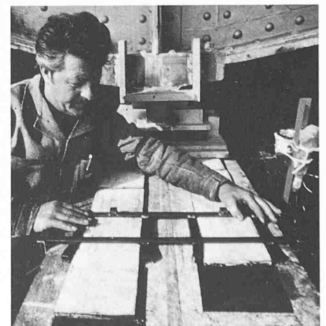
Bild 14. Einbau der teflonbeschichteten Neoprenkissen
