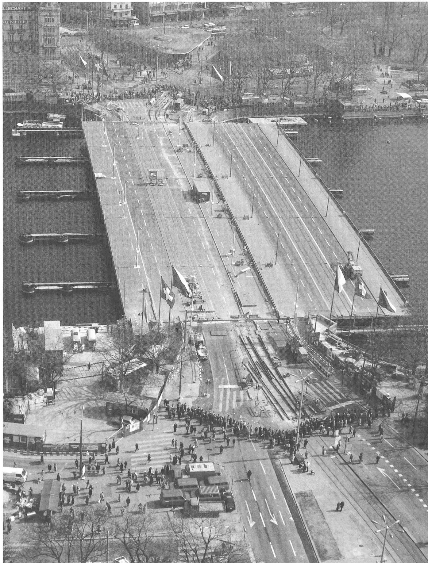
Bild 15. Luftaufnahme der Quaibrücken während des Vershubvorganges (17. März 1984), kurz vor Endlage
