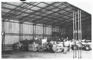
Wir projektieren und erstellen permanente oder provisorische Hallenkonstruktionen für verschiedene Bedarfsfälle. Bei Provisorien kann das Material ohne Verlust für gleiche oder ähnliche Fälle wiederverwendet werden, da die Stahlrohrkonstruktion aus einem Baukastensystem
