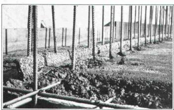
Erstellen einer Anschluss-Dichtung "BFL-MASTIX" Typ 20/70 R4.
