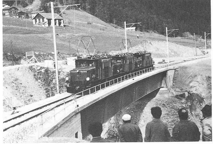
Bild 4. Belastungsprobe (Foto Zschokke Wartmann AG, Brugg)
