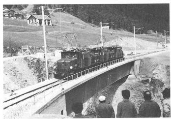
Bild 4. Belastungsprobe (Foto Zschokke Wartmann AG, Brugg)
