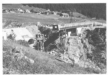
Bild 3. Einschiebephase (Foto Zschokke Wartmann AG, Brugg)
