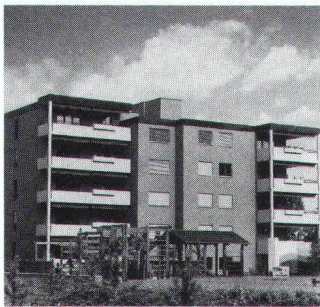
Foto: Peter Weber, BBI Bauberatung und Bauinformation
