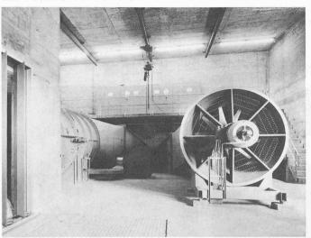
Bild 4. Strahlventilatoren im Haupttunnel Richtung Luzern
