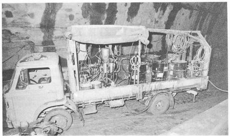
Bild 4. Mobile PU-Injektionsanlage
