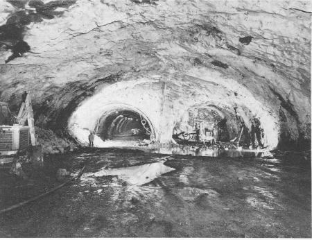
Kalottenausbruch in der Verzweigung. Links Haupttunnel Richtung Luzern mit Stahleinbau zur Sicherung des Mittelpfeilers, rechts Beginn des Ausbruchs im Anschlusstunnel
