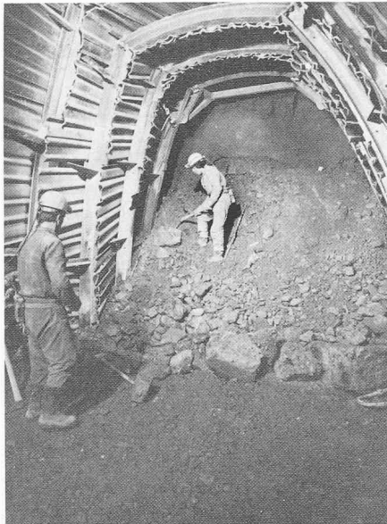
Bild 5. Oberer Paramentstollen Marciavanti-Vortrieb mit Hilfsbogen. Ortsbrüst im oberen Bereich mit Spritzbeton gesichert.
