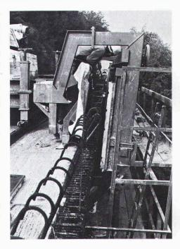
Bild 6: Die über das Innenschalungselement gezogene Vliesmatte muss straff angezogen werden, um jede Faltenbildung zu verhindern.
