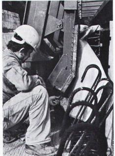
Bild 5: Die Vliesmatte wird unten im Schalwagen mittels Klemmschiene befestigt.
