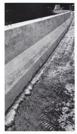
Bild 4: Die insgesamt 1136 m1 Brüstung wurden in 8 m-Tagesetappen mittels Schalwagen betoniert. Der engen Radien wegen (R. min. = 190 m) konnten die Schalwände für konvexe und konkave Betonoberflächen beliebiger Radien eingestellt werden.
