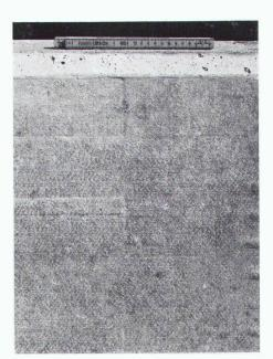
Bilder 1 + 2: Links Beispiel der bis anhin üblichen Innenflächen von Brückenbrüstungen mit starker Lunkerbildung. Rechts ein gleiches Element, dessen Innenschalung mit einer Vliesmatte abgedeckt war.
