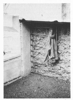
Bild 4. Freigelegte Ankerköpfe und bereits gekoppelte Armierung
