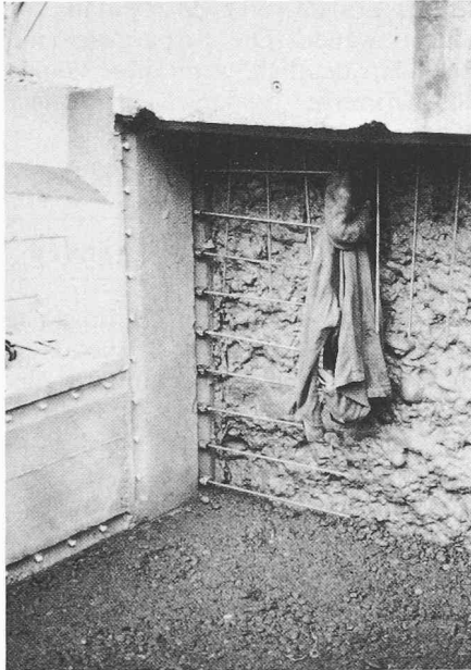
Bild 4. Freigelegte Ankerköpfe und bereits gekoppelte Armierung
