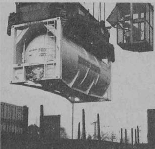
port von rieselfähigen Gütern, die mit einem Betriebsdruck von 2 bar entleert werden, sind bei der Firma Cargowaggon GmbH, Frankfurt, im Einsatz. Es handelt sich hierbei um 20'-Container (etwa 6,1 m) mit einer Außenbreite von 2500 mm mit dem bewährten Auslauf aus dem kippbaren Silo-Programm, der eine ausgezeichnete Restlosentleerung gewährleistet.
