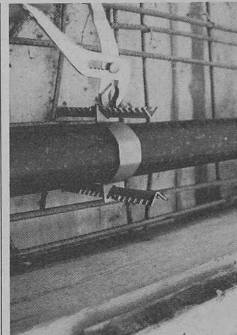
stimmt und die unteren Nocken mit einer Zange nach innen gebogen. Nachdem das Oberteil aufgesetzt worden ist, müssen nur noch die oberen Nocken eingebogen werden. Diese Befestigung ist so stabil, dass alle weiteren Arbeiten bedenkenlos ausgeführt werden können.
