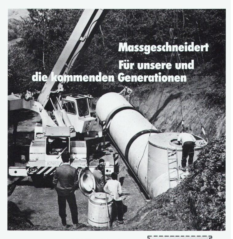
Im Juni 1984 wurde dieses in unserem Werk Niederurnen vorfabrizierte Wasserreservoir mit 38 m³ Nettoinhalt in Densbüren AG innerhalb von weniger als drei Stunden eingebaut. Es enthält alle Armaturen sowie eine Betontrennwand zwischen Nass- und Trockenkammer. Der aus drei fünf Meter langen «Eternit»-Rohren mit einem Durchmesser von 2000 mm zusammengesetzte Behälter erwies sich im Vergleich zu Ortsbeton als kostengünstiger.
