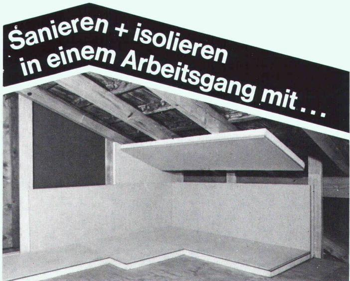
**WESPAN-Normisolierelemente sind als Boden-, Wand- und Deckenisolierplatten genormt, allseitig genutet und einseitig mit Polystyrol-F20 oder mit Flumrocplatten beschichtet. Div. Platten- und Isolationsstärken. K-Werte bis 0,32 W/m<sup>2</sup> K. Einsparung von ca. 30–50% Arbeitskosten. Isolieren, sanieren in einem Arbeitsgang. Keine Kältebrücken u. Fugen (Nut- und Federverleimung).**
