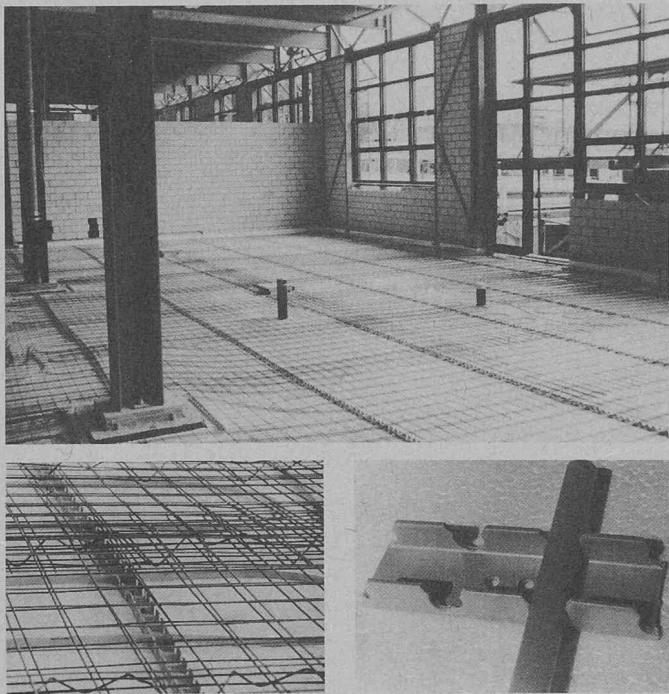
Auf den ersten Blick unterscheidet sich die abgebildete Montageschiene für Bodenheizungsrohre kaum von ähnlichen Produkten. Bei näherer Betrachtung jedoch zeigt die Unitex-Neuheit neue material- und anwendungstechnische Eigenschaften:
