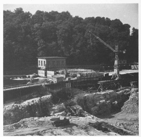
Aushub im Rheinbett für das Kraftwerk Schaffhausen, Blick nach Süden. Man beachte die Klüftung des Kalkfelsens und das Ausmass des Aushubs (Foto R. Fechtig 27.7.1961)
