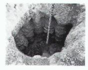
Das Gestänge wird zuerst auf die ge wünschte Tiefe eingebohrt, dann bei gleichzeitiger Injektion langsam zurückgedreht. Der umliegende Boden wird vom strahlenartig austretenden Injektionsgut durchsetzt und zylinderförmig verfestigt.
