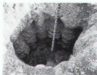
Das Gestänge wird zuerst auf die gewünschte Tiefe eingehobt, dann bei gleichzeitiger Injektion langsam zurückgedreht. Der umliegende Boden wird vom strahlenartig austretenden Injektionsgut durchsetzt und zylinderförmig verfestigt.
