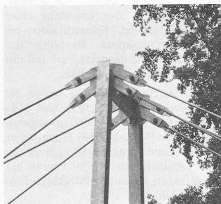
Bild 6. Pylonkopf mit Anschluss der Zugstangen
