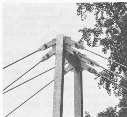
Bild 6. Pylonkopf mit Anschluss der Zugstangen
