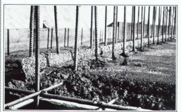
Erstellen einer Anschluss-Dichtung "BFL-MASTIX" Typ 20/70 R4.
