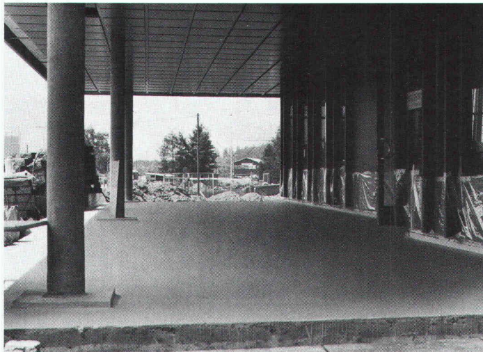
Eingangshalle Kläranlage Als wasserdichte Isolation unter Plattenbelag
