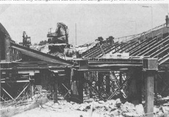
Bild 3. Abbruch der Nordbrücke mit einem japanischen 120-t-Betonbeisser Kami Kami auf Stahlgerüst, das auch als Lehrgerüst für die neue Brücke dient
