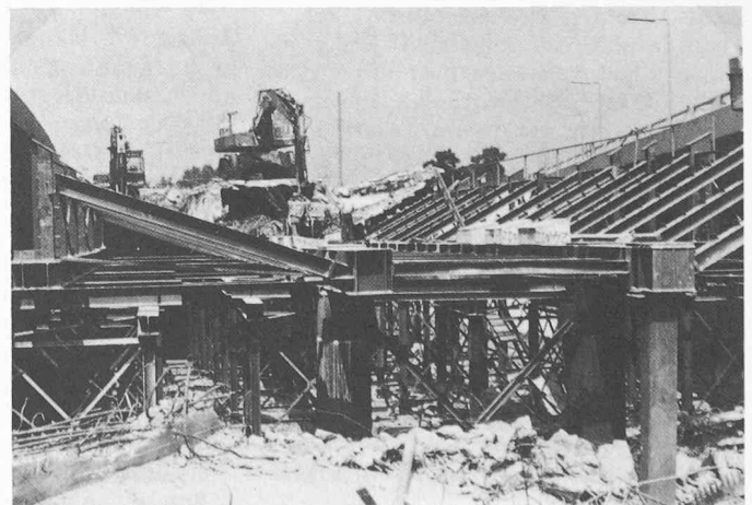
Bild 3. Abbruch der Nordbrücke mit einem japanischen 120-t-Betonbeisser Kami Kami auf Stahlgerüst, das auch als Lehrgerüst für die neue Brücke dient
