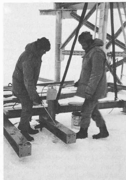
Bild 15. Stahlbaumonteur mit Windjacke und Pelzmütze (statt Bauhelm)
