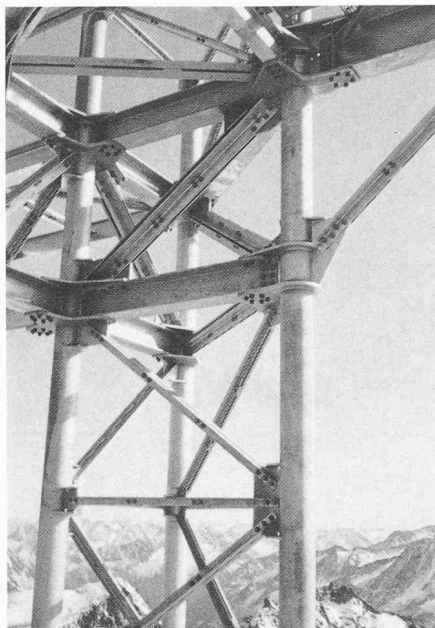
Bild 9. Antennenträger: Rahmenknoten mit Dreigurtriegeln und Anschluss einer Terrassenkonsole
