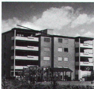
Foto: Peter Weber, BBI Bauberatung und Bauinformation
