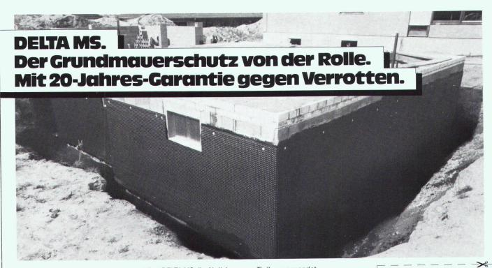
Das Entscheidende: Die Noppen-Struktur. Durch die ca. 8 mm hohen Noppen wird das feuchte Erdreich sicher vom Mauerwerk getrennt. Beim Verfüllen der Baugrube
