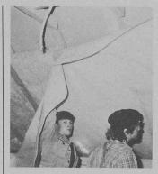
selbstverlöschenden Polyäthylen-Produkt zugleich brandhemmend ausgeführt. Die Lieferbreiten von zwei und drei Metern ermöglichen wirtschaftliches Verlegen. Die neue, 0,2 mm starke Folie trägt die Brandkennziffer V.2. Der Wasserdampfdiffusionswiderstand R<sub>D</sub> beträgt 85 (m2hPa/mg).
