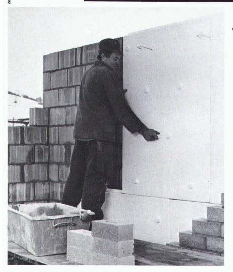
die feuchtigkeitsunempfindliche Isolationsplatte im Zweischalenmauerwerk: praktisch kein Kondensatanfall, dauerhafter Wärmedämmwiderstand für Jahrzehnte!
