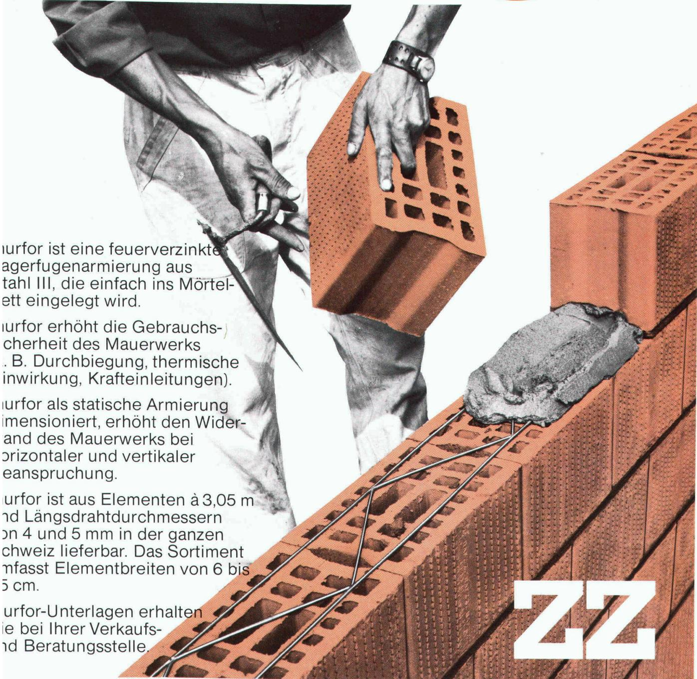
murför ist eine feuerverzinkte, aber fugenarmierung aus stahl III, die einfach ins Mörtelbett eingelegt wird.
