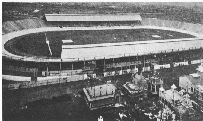
Bild 5. White City Stadium in London, 1908. Erstmals eine geschlossene Tribüne mit längsseitiger Überdachung
