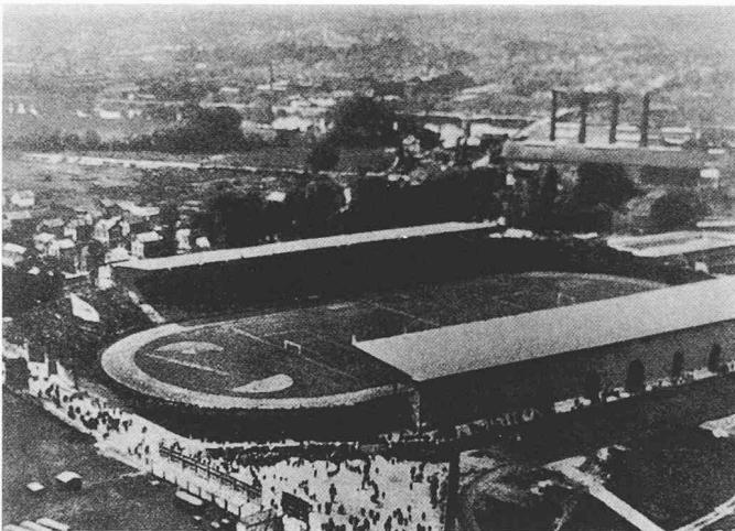
Bild 13. Olympia-Stadion in Paris-Colombes, 1924. Entstand im Zusammenhang mit einem Sportpark
