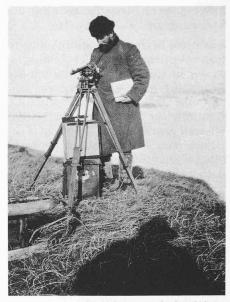
Bild 6. E. K. Weber führt im Frühjahr 1910 am Kap Deschnew, während er auf das Schiff aus Wladiwostok wartet, eine astronomische Ortsbestimmung mit dem Universalinstrument aus
