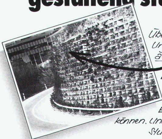
Überall, wo ein steiler Abhang Unterstützung braucht und erst noch ästhetisch aussehen soll, ist Murflex® mehr als am Platz. Die optimal begrünbare Raumgitter-Konstruktion, mit welcher – flexibel – entsprechend den örtlichen Gegebenheiten auch Nischen, Abtreppungen und Ecken ausgebildet werden können. Und – die in Notfällen innerhalb Stunden ab Lager lieferbar ist.
