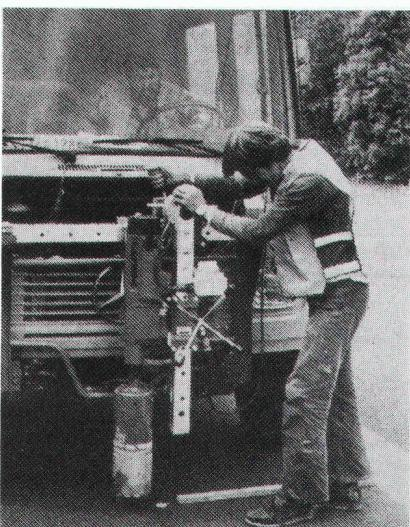
Derzeit bohrt die Spezialfirma Ribbert mit einem eigens dafür entwickelten Kernbohrer die Löcher für die zukünftigen Leitpfähle entlang der Strasse.
