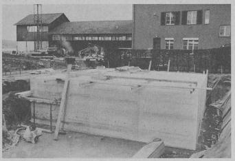
blem der Standfestigkeit (Auftrieb) des Tanks führten zur Wahl eines ortsgefertigten Betontanks, System Borsari. Diese Lösung ermöglicht die Lagerung einer grösstmöglichen Menge Dieselöl (160 000 l). Die Fläche über dem Tank kann zu Lagerzwecken oder für eine Grünanlage verwendet werden. Der Betontank ist innen mit einem glasfaserverstärkten Polyester-Doppelmantel Borsafoil ausgekleidet. Der Zwischenraum wird mit einem Vakuum-Leckanzeigegerät dauernd überwacht.
