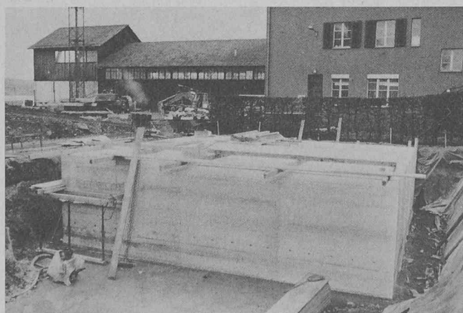
Zürichsee-Schiffahrtsgesellschaft Zürich. Dieselöltank in Stahlbeton (160 000 l), 1983
