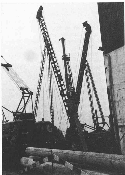
Bild 15. Rammeinrichtungen, die auf engstem Raum arbeiten
