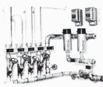
elektrophysikalische Kalkund Korrosionsschutzanlagen
