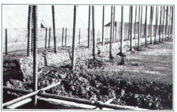
Erstellen einer Anschluss-Dichtung "BFL-MASTIX" Typ 20/70 R4.
