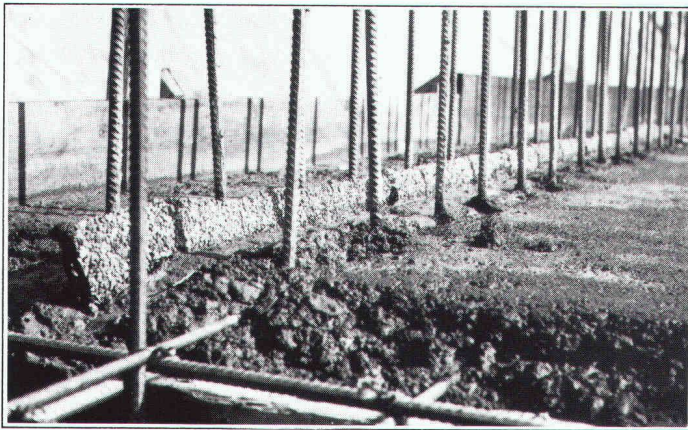
Erstellen einer Anschluss-Dichtung "BFL-MASTIX" Typ 20/70 R4.
