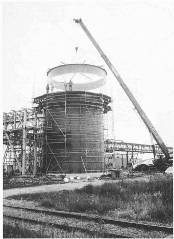
Das Dach des Grossbehälters (in Klöpperbodenform) besteht aus zwölf Einzelsegmenten, die über Flansche miteinander und mit dem Zylinder verschraubt und verklebt werden
