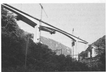
Biaschina-Viadukt (N 1 in der Leventina). Freivorbau. Bauzustand 1982
