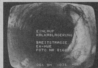
Auf dem Monitor werden Messwerte wie Distanz, Längsgefälle und Querverneigung im Fernsehbild festgehalten
