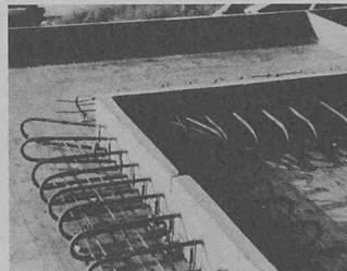
Fällen Vorteile beim Baufortschritt bringen kann. Die Normalelemente sind für Dekkenstärken von 18-25 cm und Auskragungen bis etwa 2,20 m vorgesehen. Spezialelemente werden auf Wunsch hergestellt. Für die Bemessung dienen einfache Moment/Querkraft-Diagramme, in welchen auch sämtliche auftretenden Schnittkräfte durch Verformung berücksichtigt sind. Die Senkung an der Kragplattenspitze ist gering, und die Gesamtbalkenkonstruktion zeigt keine Anfälligkeit auf Schwingung.
