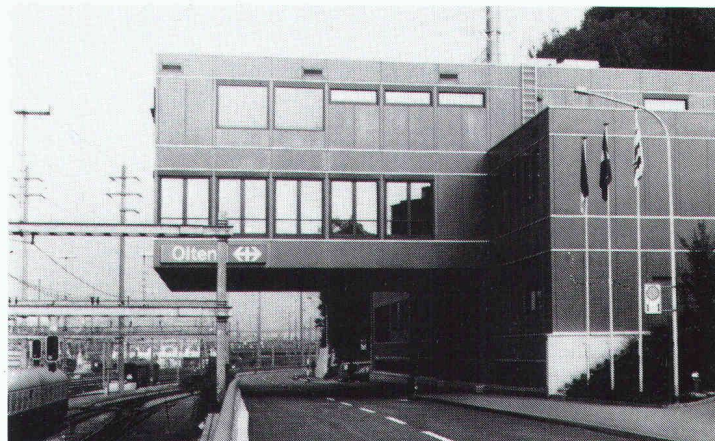
Neues Stellwerk Bahnhof SBB, Olten, Fahrbahnisolierung
