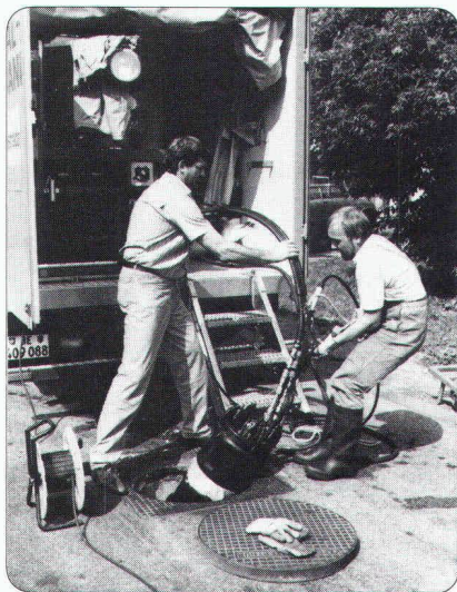
Sanierungsarbeiten mit dem Penetryn-Muffenabdichtungsverfahren.
