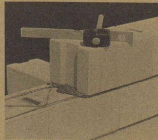
gelegt. Selbstverständlich weist der neue Blockstein alle bekannten Vorteile des Hebel-Mauerwerks auf, wie ausgezeichnete Wärmedämmung, geringes Gewicht, hohe Feuersicherheit und gesundes Wohnklima. Die Wärmedämmung lässt sich mit dem fixfertigen Hebel-Dämmmörtel noch erhöhen, der mit den Steinen mitgeliefert wird. Als Einführungsofferte liefert Hebel zu 20 Paletten Blocksteine zwei Paletten kostenlos.
