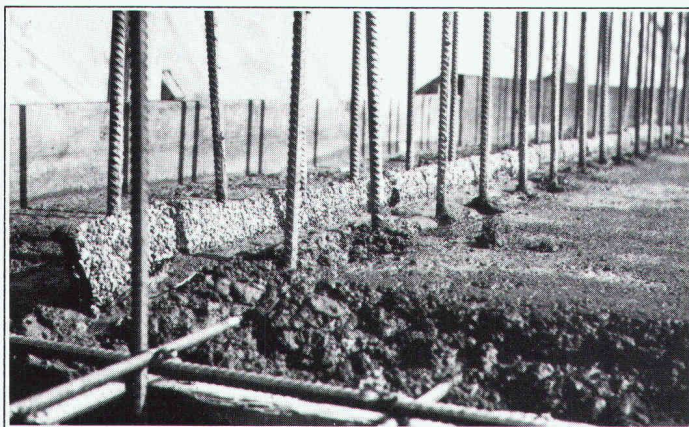
Erstellen einer Anschluss-Dichtung "BFL-MASTIX" Typ 20/70 R4.
