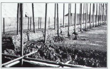
Erstellen einer Anschluss-Dichtung "BFL-MASTIX" Typ 20/70 R4.
