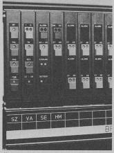
Überwachungsteil der Brandmelde-zentrale BMZ-85
