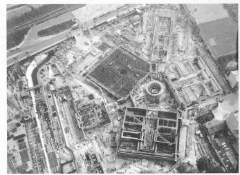
Entphosphatungsanlage, Bauzustand. Blick auf das Mittelbauwerk mit Verteilerturm und die drei stern förmig angeordneten Filtergebäude
