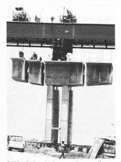
Bild 8. Einbau der Segmente für einen Überbau (Bild 7), alle an einem Gerüst hängend
