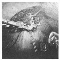
Bild 16. Spritzbetoneinbau im Firstbereich im Tunnelbau
