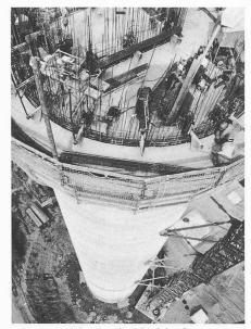
Bild 12. Heizkraftwerk Altbach bei Stuttgart; runder Treppenturm mit innenliegendem eckigem Schacht-gleitgeschalt
