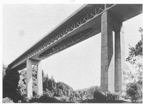
Bild 1. Spannbetonfachwerkbrücke der Bundesautobahn Regensburg-Passau; Mangfallbrücke mi. 90-108-90 mSpannweiten
