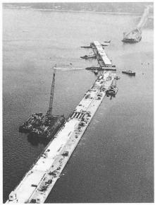
Schwimmende Betonbrücke über den Hood-Canal-Meeresarm in den USA
