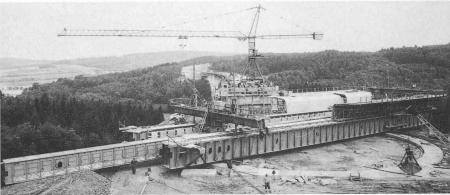
Bild 10. Talbrücke Döllbach; Drehen der Vorschubrüstung
