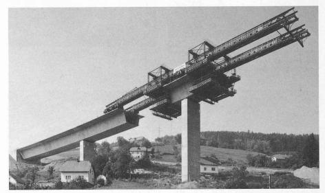
$Bild~11. \quad Auenbach-Tal\"{u}bergang~mit~10\times70~m~Spannweiten, S\"{u}dautobahn~A2, K\"{a}rnten~$
