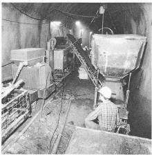
Spritzbetoneinheit bei druckluftgebunde-Bild 17. nem Gleisbetrieb
