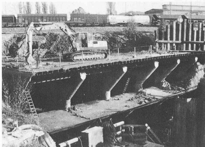
Bild 19 (unten). Einpress-tunnel von Bild 18 nach dem Durchstich
