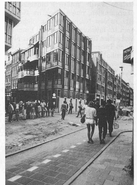
Amsterdam: Verwaltungsgebäude in der Innenstadt
