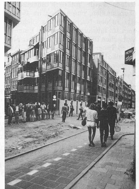
Amsterdam: Verwaltungsgebäude in der Innenstadt
