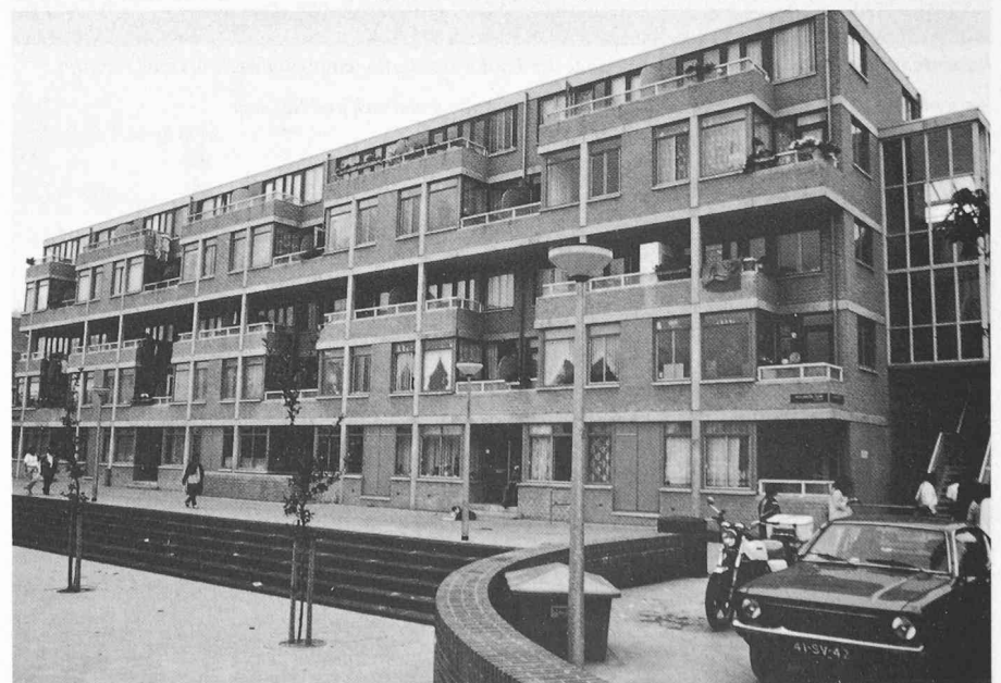
Amsterdam: Wohnhäuser am Westerdok ; Architekten: P. de Ley
