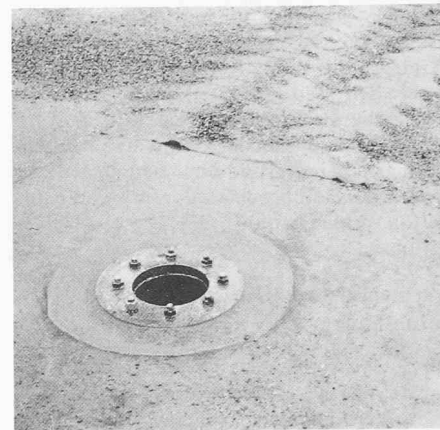
Bild 6. Einführung des Drainagewassers der oberen Drainage über der unteren KDB. Die Dichtungsbahn wird nach bewährtem System an den kreisrunden Flansch des Rohres mit einem darüberliegenden und durch Schrauben festgeklebten Flansch direkt an das in die untere Drainagekammer führende Rohr angeschlossen (Foto: Sarna Kunststoff)
